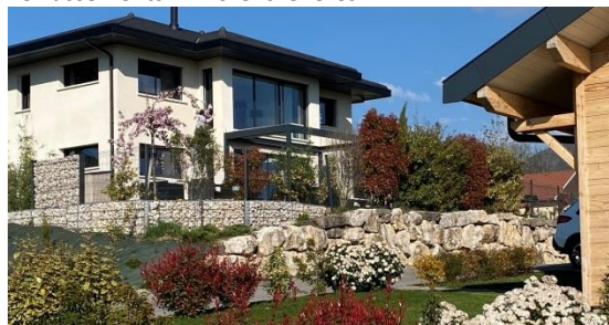
Succession de soutènements de gabions ou d'enrochement – Les Ollières
